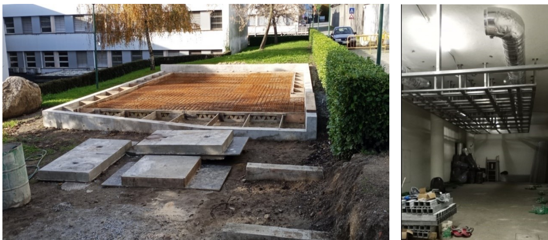
Figura 2 - Fotografias de pormenores das obras que decorriam em Azurém em dezembro de 2022. Da esquerda para a direita: Laje de betão que estava a ser construída em dezembro de 2022 em Azurém para receber a estação água refrigerada para o Deucalion, Pormenor da estrutura de teto no espaço interior para alojar o Deucalion em Azurém.
